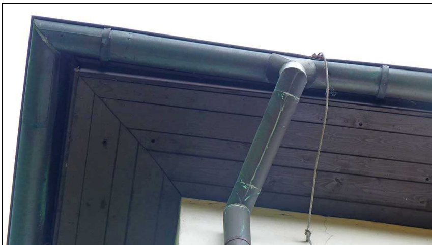
Střešní přesah budovy B doléhá k obvodovému plášti těsně bez štěrbin.
